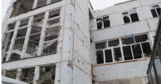
Часть поврежденных прикрыты фанерой, но есть и серьезные, с провалами в стенах и обвалившимися балконами
